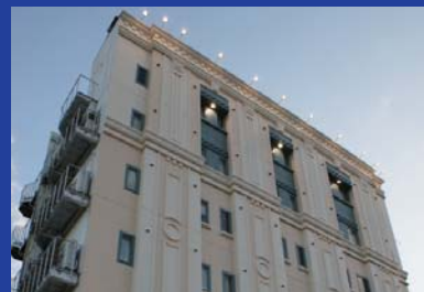
ALC・鉄骨造
