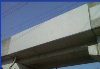
橋桁・橋脚・橋台、等
