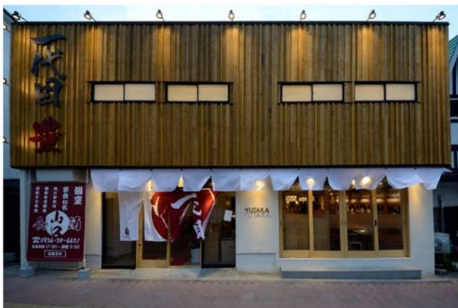
店舗改修工事（居酒屋）
