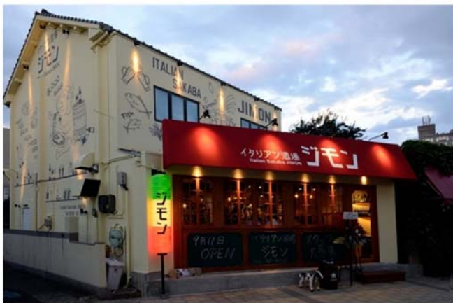
店舗改修工事（イタリアン酒場）
