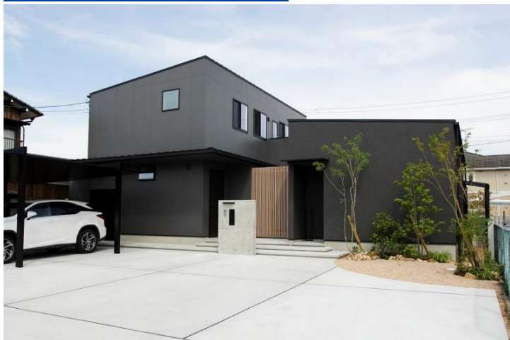
新築工事（戸建て住宅）
