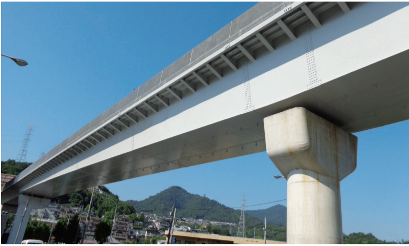
安川渡河部の高架橋 (剥落対策など補修済み)
