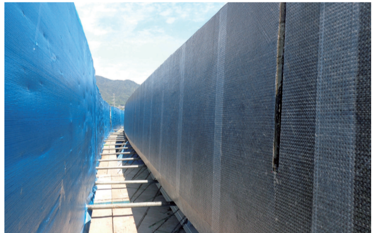
山陽自動車道との交差部付近で補修進む(スケルトン工法)
