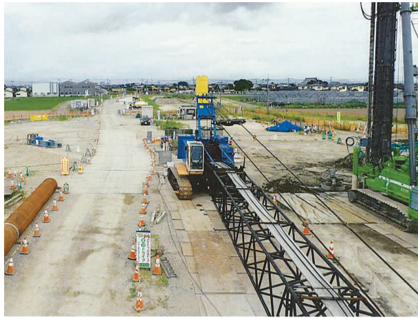
東与賀 I.C. 橋建設現場
