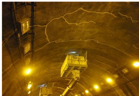
吹付けモルタルトンネル
