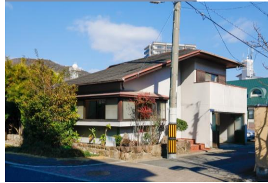
施工前 戸建て住宅
