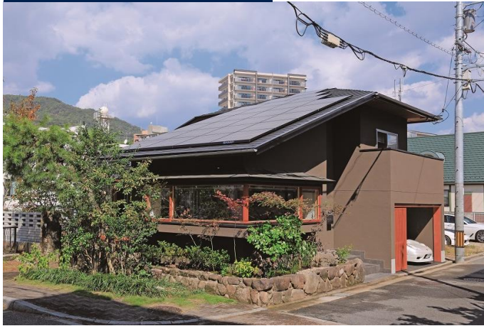
施工後 戸建て住宅
