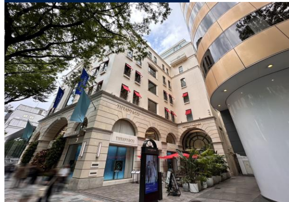
施工後 結婚式場
