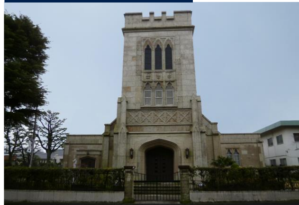
施工後 歴史的建造物
