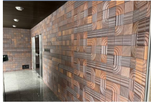
施工前 デザインタイル
