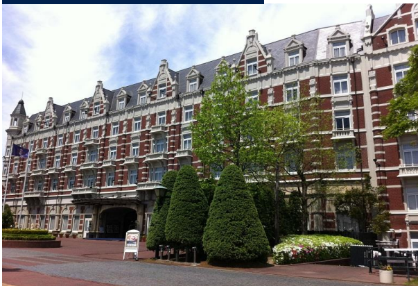
施工後 テーマパーク
