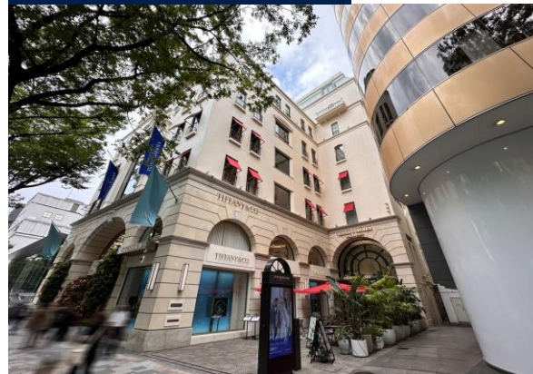
施工後 結婚式場
