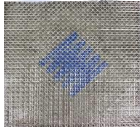
ガラス連続繊維シート貼付け
