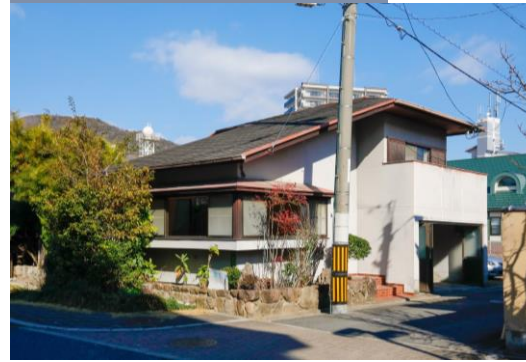
施工前 戸建て住宅
