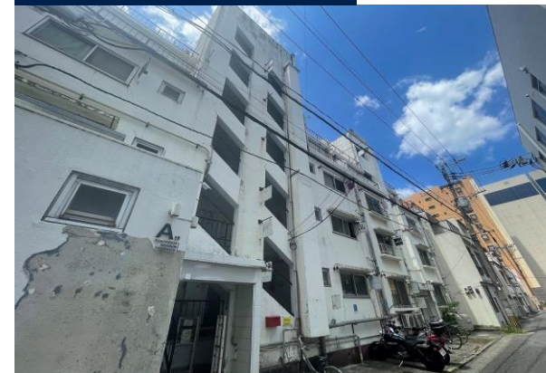
施工後 国有文化財
