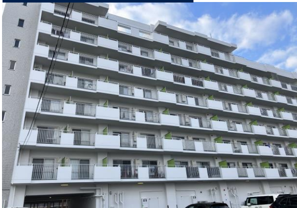
施工後 集合住宅
