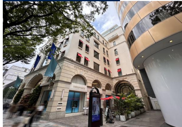
施工後 結婚式場
