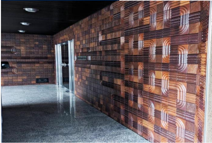
施工後 デザインタイル
