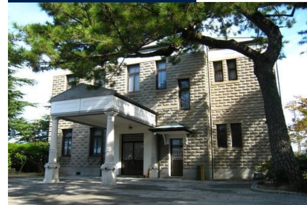
施工後 国有文化財
