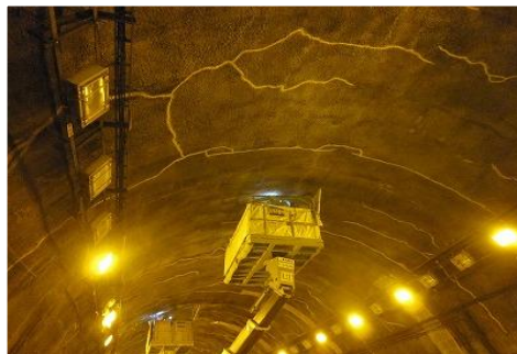
吹付けモルタルトンネル
